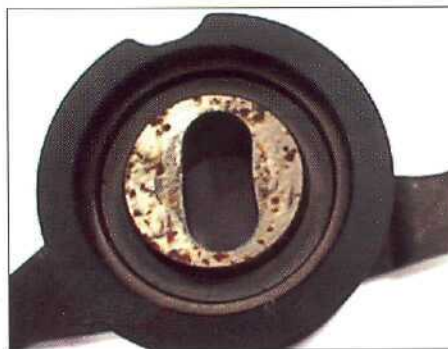
Обширные очаги коррозии. Срок службы ролика превысил его ресурс.
