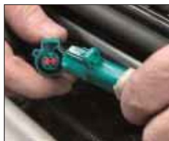
Проверьте все электрические соединения
